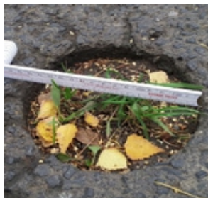
Kairėje – Ø 15 cm gręžimo anga, dešinėje – užtaisytos keliais sluoksniais angos pjūvis.
